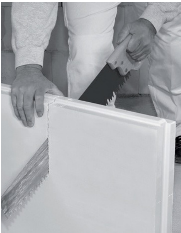
Kipsist seinaplokkide paigaldamine majakarbi ehituse etapis
