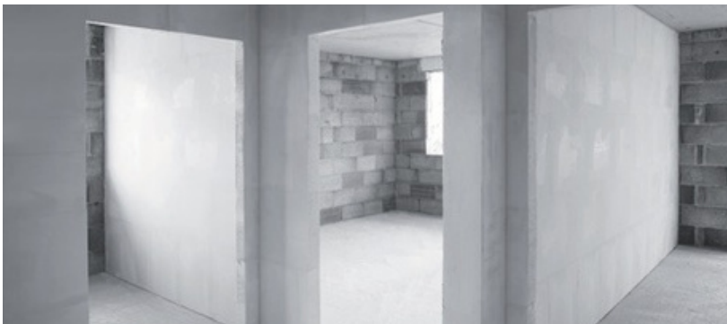
Kipsist seinaplokkide paigaldamine majakarbi ehituse etapis
