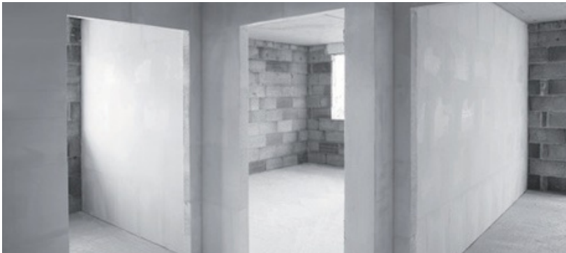
Kipsist seinaplokkide paigaldamine majakarbi ehituse etapis
