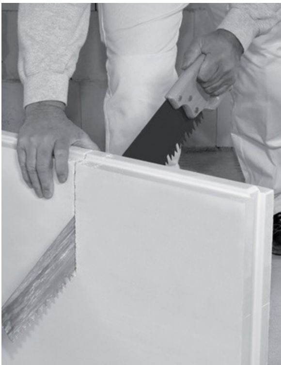
Kipsist seinaplokkide paigaldamine majakarbi ehituse etapis
